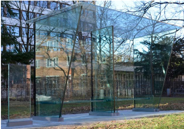
Lastabtragende Klebverbindung im konstruktiven Glasbau
